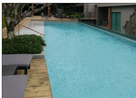
รูปที่ 3-42 รางระบายน้ำล้น มีฝาปิดรอบสระว่ายน้ำ ไม่เป็นสนิม แข็งแรง ทำความสะอาดง่ายอยู่ในสภาพดี
