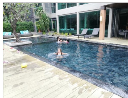
รูปที่ 3-42 รางระบายน้ำล้น มีฝาปิดรอบสระว่ายน้ำ ไม่เป็นสนิม แข็งแรง ทำความสะอาดง่ายอยู่ในสภาพดี
