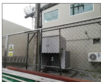
รูปที่ 3-24 หม้อแปลงไฟฟ้าแยกเฉพาะ และอยู่ในสถานที่ซึ่งบุคคลที่มีหน้าที่เกี่ยวข้องเข้าได้โดยสะดวก
