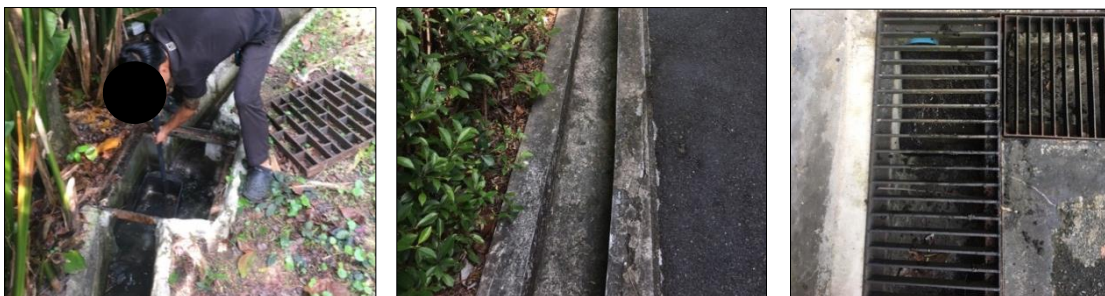
รูปที่ 3-13 เจ้าหน้าที่ขุดลอกท่อระบายน้ำของโครงการและท่อระบายน้ำภายในโครงการไม่มีสิ่งอุดตัน
