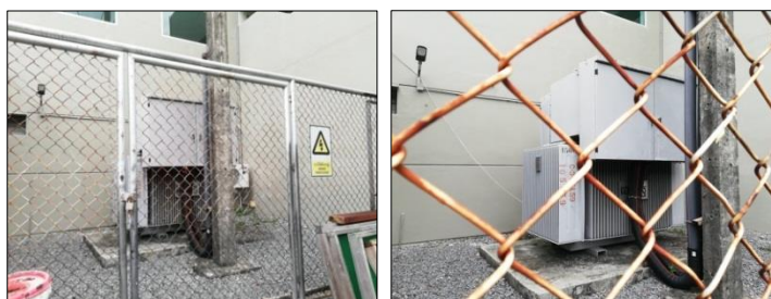
รูปที่ 3-23 แผงกั้นที่ทำด้วยวัสดุทนไฟล้อมรอบหม้อแปลงไฟฟ้า
