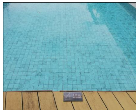
รูปที่ 3-44 ป้ายบอกความลึก หรือเลขบอกระดับความลึกที่สามารถมองเห็นได้ชัดเจน
