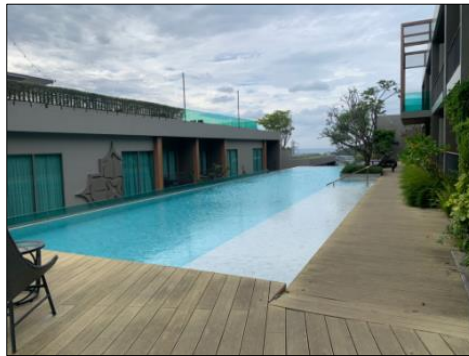
รูปที่ 3-43 พื้นที่ว่างเป็นทางเดินรอบสระว่ายน้ำ ความกว้างไม่น้อยกว่า 1.20 เมตร ไม่ลื่น ไม่มีน้ำขัง และสามารถทำความสะอาดง่าย
