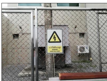
รูปที่ 3-24 หม้อแปลงไฟฟ้าแยกเฉพาะ และอยู่ในสถานที่ซึ่งบุคคลที่มีหน้าที่เกี่ยวข้องเข้าได้โดยสะดวก
