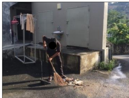
รูปที่ 3-2 พนักงานล้างทำความสะอาดถนน และทางเดินภายในโครงการเพื่อลดการฟุ้งกระจายของฝุ่น
